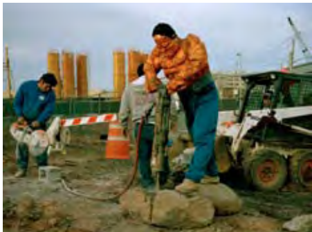
The Thing LUIS HERNANDEZ de l'Etat de Veracruz. Il travaille comme manoeuvre sur des chantiers de démolition à New York. Il envoie 200 dollars par semaine. référence image: PIN_I I _028
